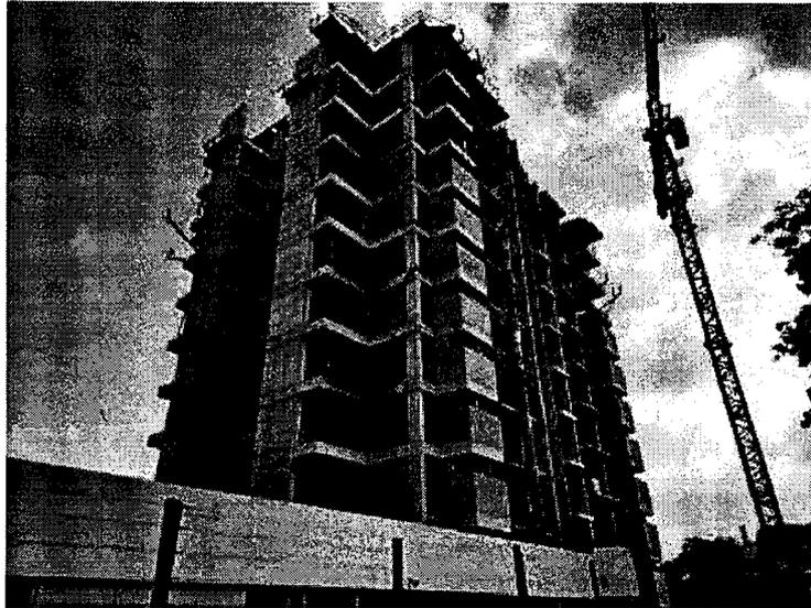
**Foto 1. Avance en trabajos de obra, mampostería fachada niveles 7mo-9no, armado losa de cubierta ejes (H-L y 3-5) – Torre B.**
