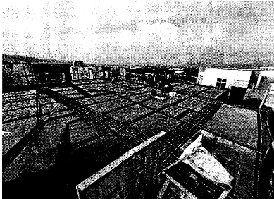
**Foto 13. Avance aligeramiento, colocación conexiones eléctricas, losa cubierta – Torre B.**
