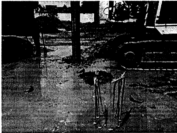
Foto 9. Perforación de pilotes – Torre B.
