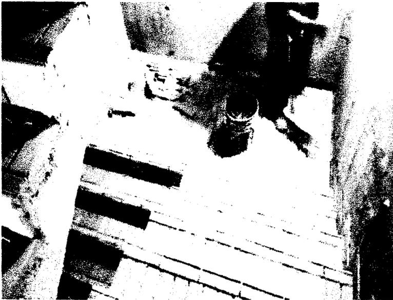
Foto 19. Instalación de tableta de gres en escaleras de acceso apartamentos - Torre E.
